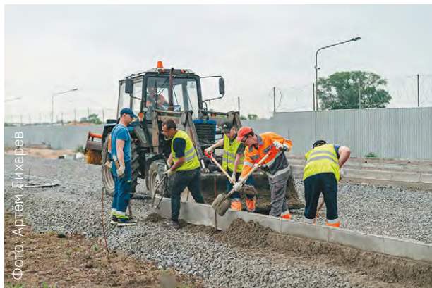
▲ Ремонт дороги на улице Элеваторной.
